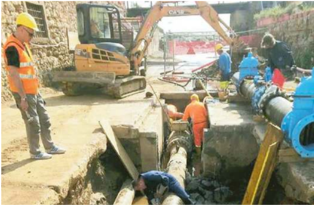
Lavori alla condotta sottomarina a Rio Marina
