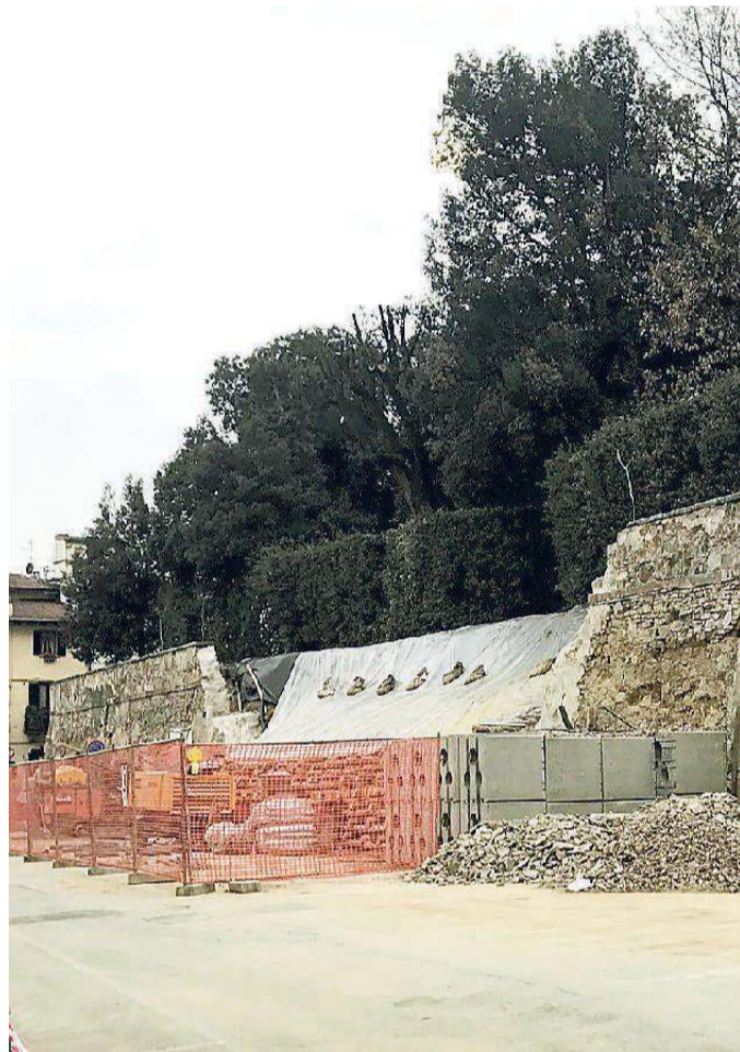
La parte di muro che verrà ricostruita
