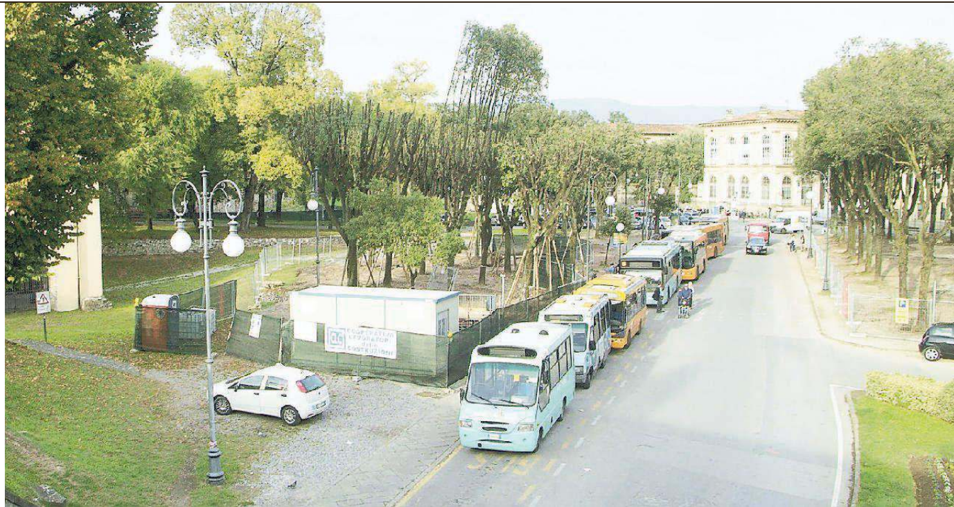
Lavori in piazzale Verdi all'epoca degli interventi per il Piuss
