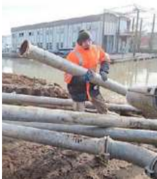
Sostituzione di tubi
