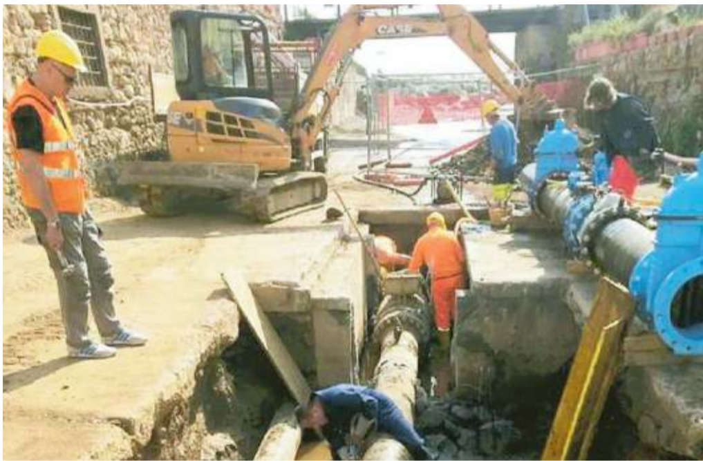
Lavori alla condotta sottomarina a Rio Marina
